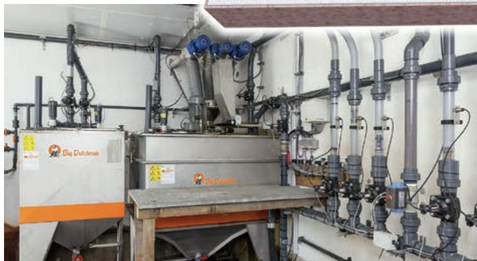
Кормокухня: система с 1 емкостью, БТВ и 4 тупиковыми линиями JET
