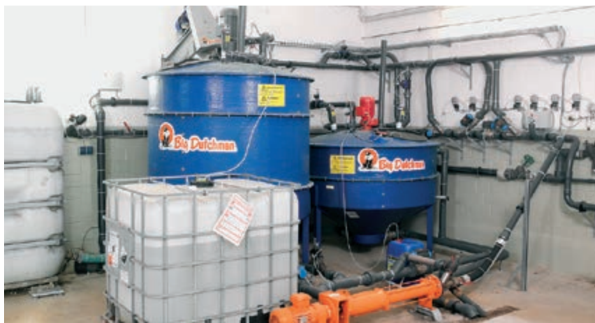
Кормокухня: система с 1 баком и взвешивающим БТВ
