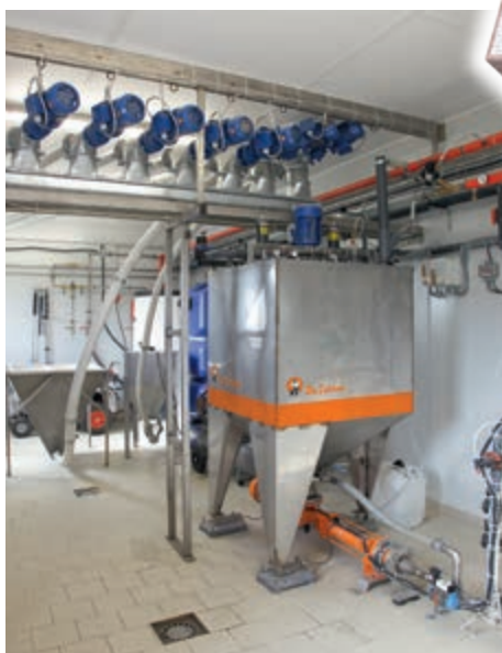
Кормокухня: система с 1 баком, безост, сжат. воздух
