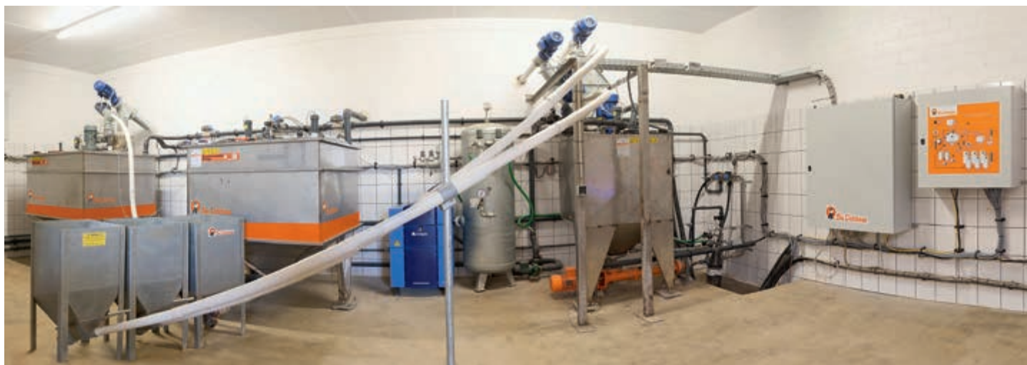
Вид на кормокухню с системой раздачи жидкого корма HydroMix на основе сжатого воздуха для площадки дорастивания поросят, а также установкой с одним баком и беззаточным кормлением на содержании свиноматок
